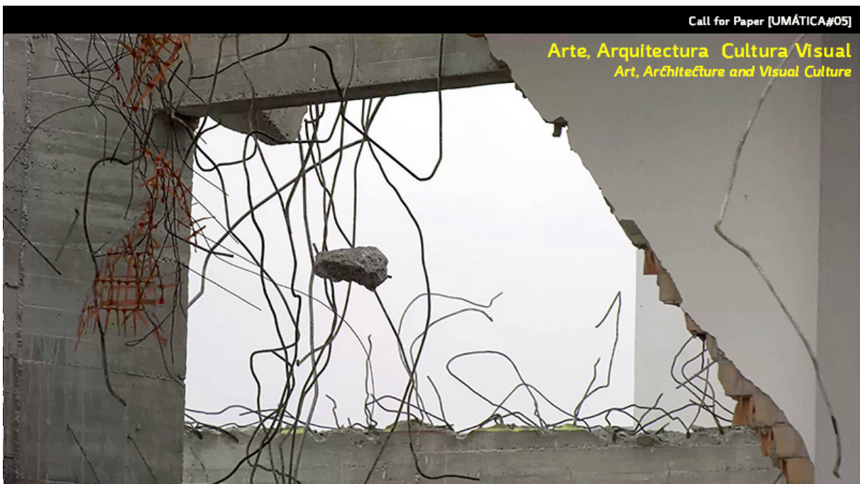
Fig 01. Demolición parcial I. Museo de los Dólmenes de Antequera (Málaga) - 2018 / J.C. Robles
