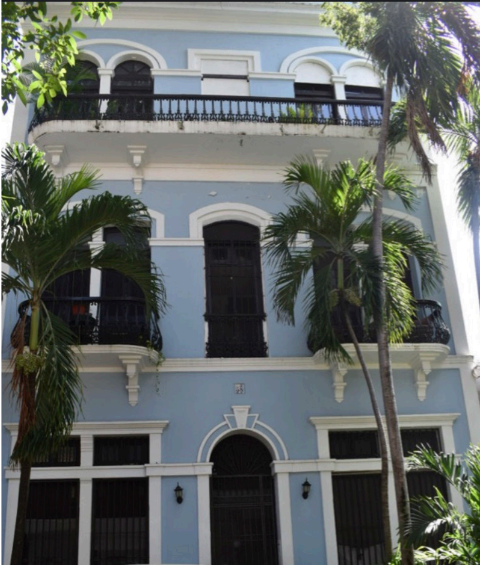
Una de las estructuras que muestra la fachada española, cerca de Casa Blanca.
