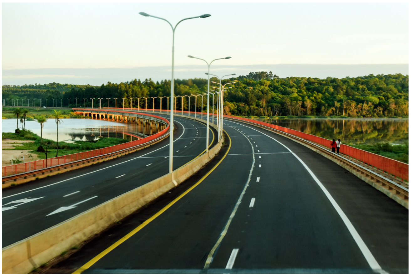
RN. 12. Puente sobre arroyo Yabebiry, entre Loreto y San Ignacio. (Tatiana Lencina).
