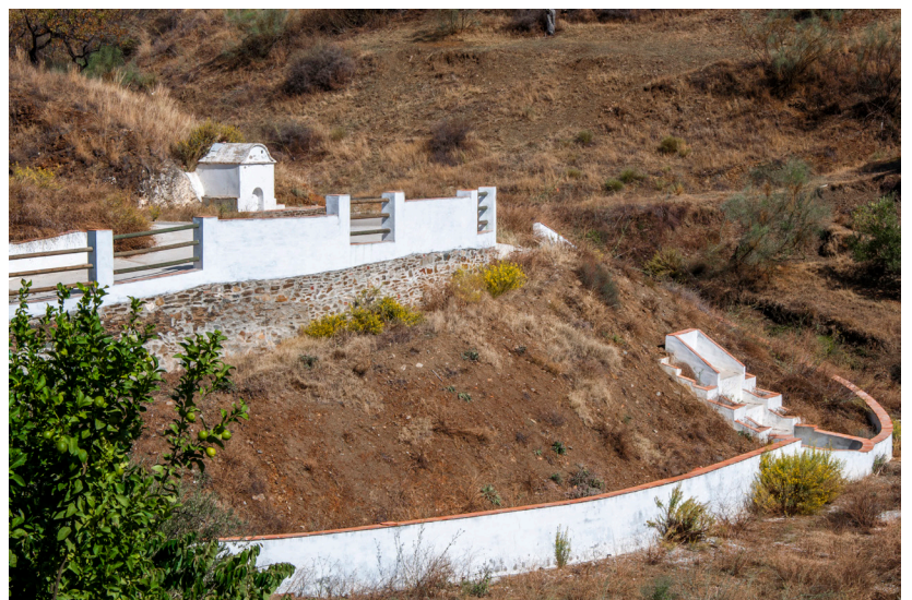
Vista de una fuente recuperada recientemente.
