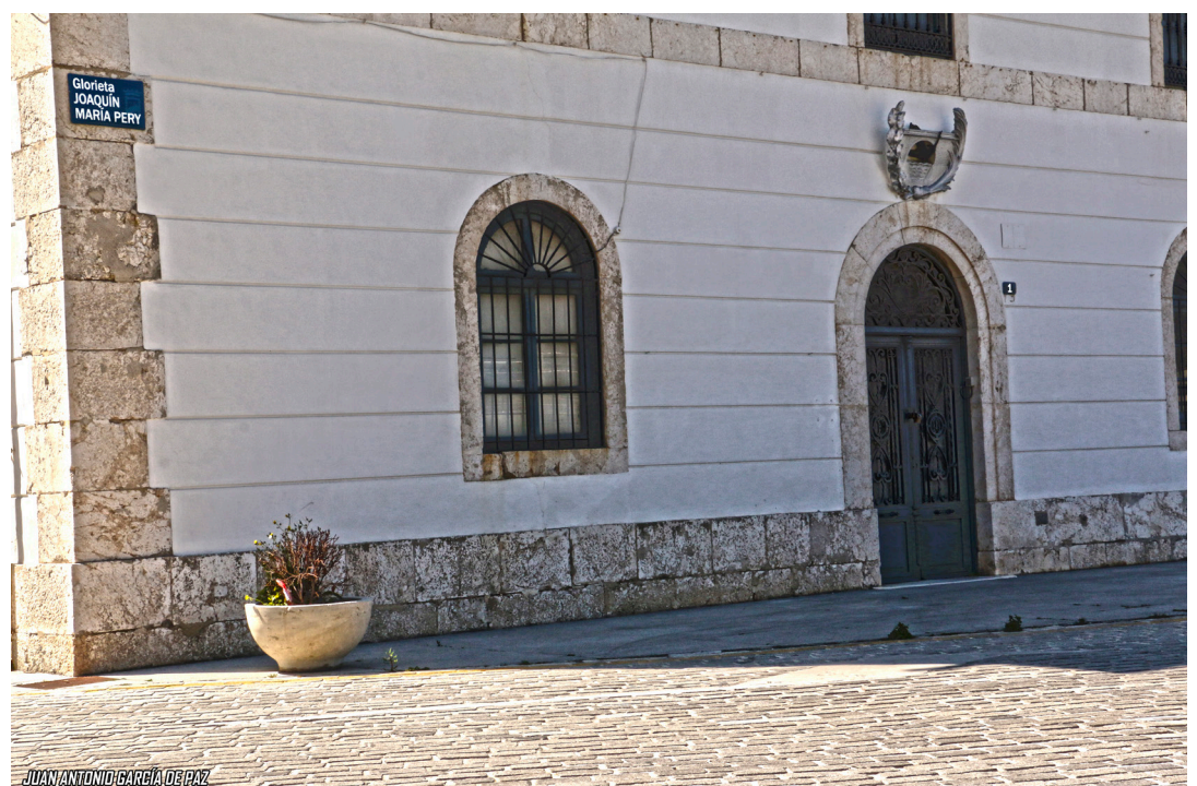
Detalle de la fachada principal
