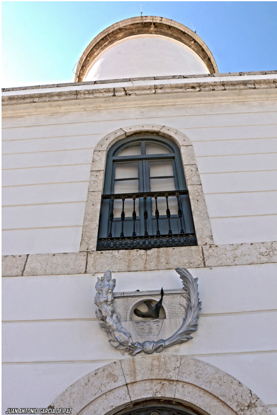
Detalles de la fachada principal
