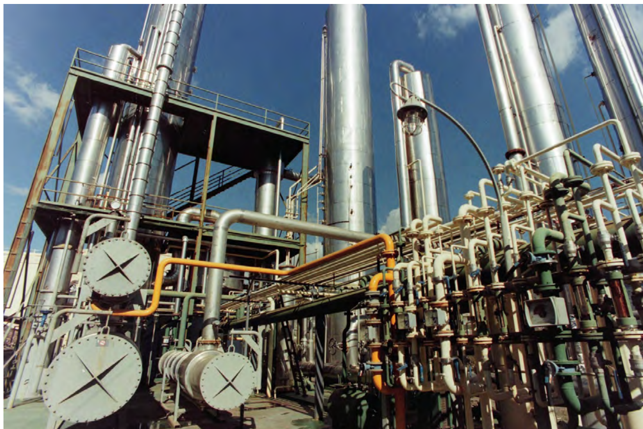
Entramado de columnas de rectificación de alcoholes, de donde se obtiene el ron motrileño.
