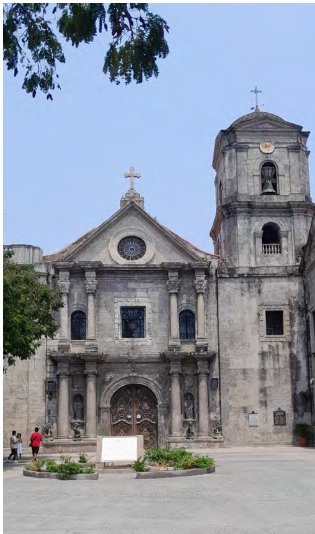
San Agustín (Manila). Compás y fachada de la iglesia. (Foto: Javier Galván Guijo).
