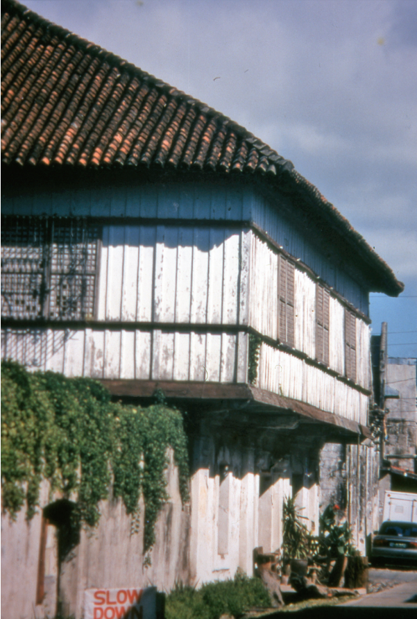
Edificio con cubierta original de teja. (Foto: Javier Galván).
