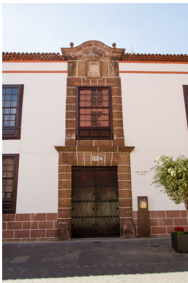
Casa Riquel. Edificación del siglo XVIII, mandada a construir por Antonio Riquel de Angulo. De su fachada destaca la portada principal de cantería roja, que incluye el escudo de armas de la familia. Se trata de una construcción de importante interés patrimonial.
