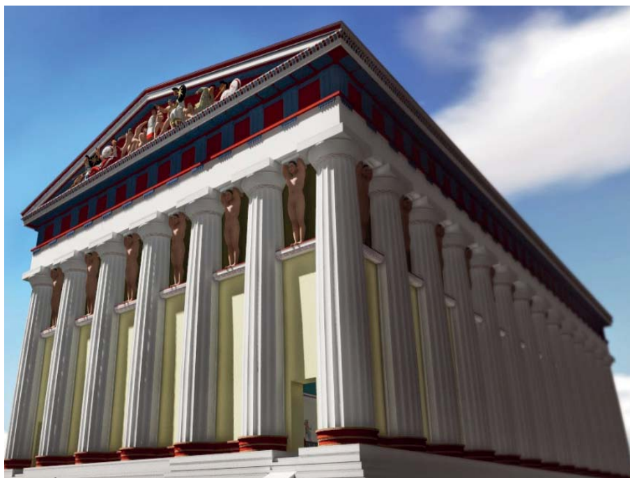
Fig. 18. Reconstrucción de Moncada (2015), con ventanas en la parte alta de los intercolumnios y atlantes a modo de parteluz.
