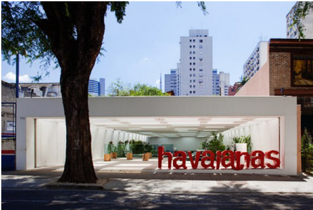
Fachada de la tienda de Havaianas en la calle Oscar Freire.
