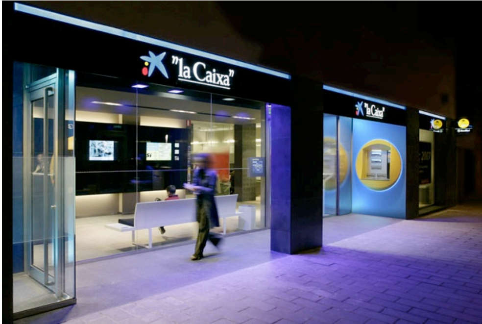
Figura 15. Oficina de La Caixa con el cajero PUNT GROC instalado. Barcelona , 2007.
