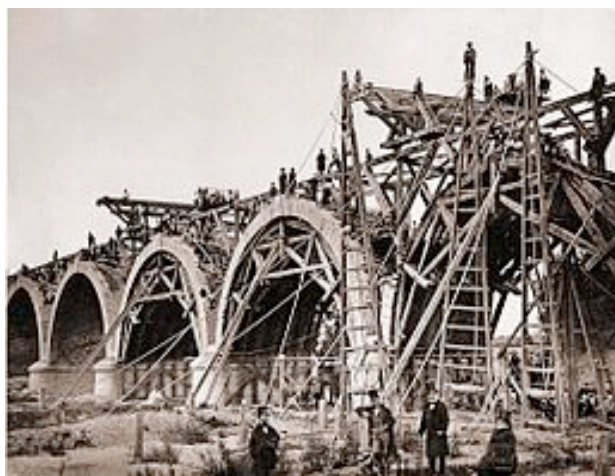
F4. Construcción del Puente de los Franceses, Charles Clifford
