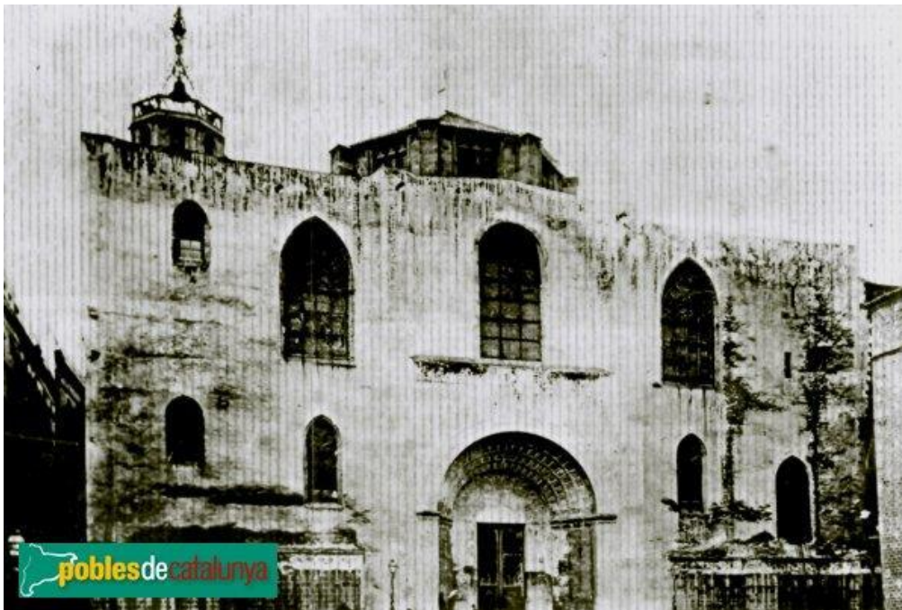
2. Antigua fachada de la Catedral de Barcelona (Poblesdecatalunya.cat).
