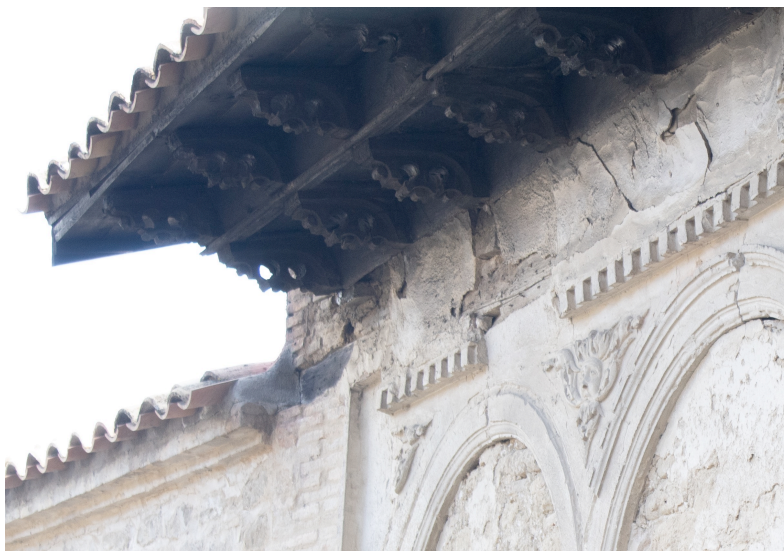
Fig. 4. Detalle de la parte superior del ala este del edificio, realizada desde el interior de este. Fotografía: autor.
