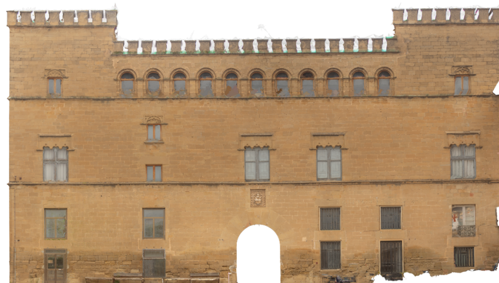
Fig. 1. Ortofotografía del alzado de la fachada sur del palacio de Ayerbe realizada a partir de fotogrametría, 2023. Fotografía: autor.
