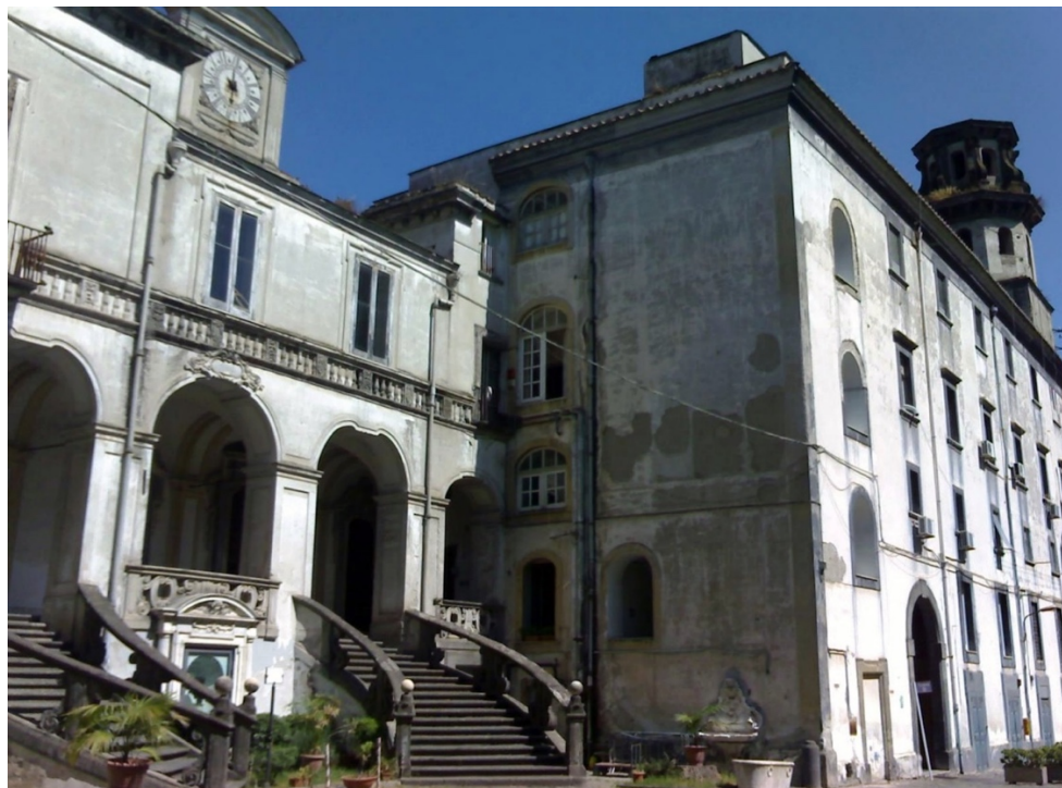
Fig. 7. Napoli. Cortile del complesso di S. Maria del Popolo degli Incurabili. Atrio d'ingresso della Farmacia storica con il blocco attiguo degli edifici.
