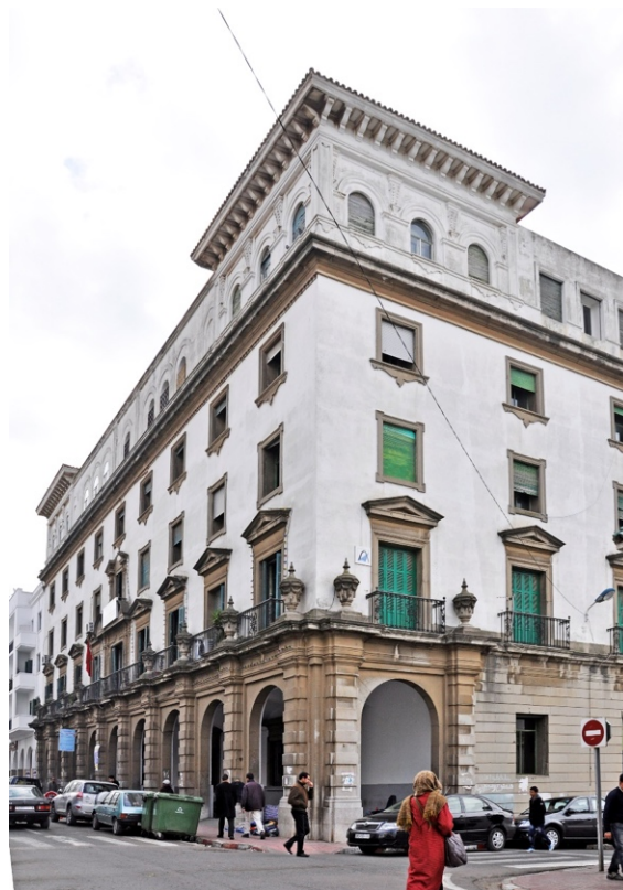
Fig. 4: Edificio de Obras Públicas, Tetuán. Fotografía: archivo del autor.
