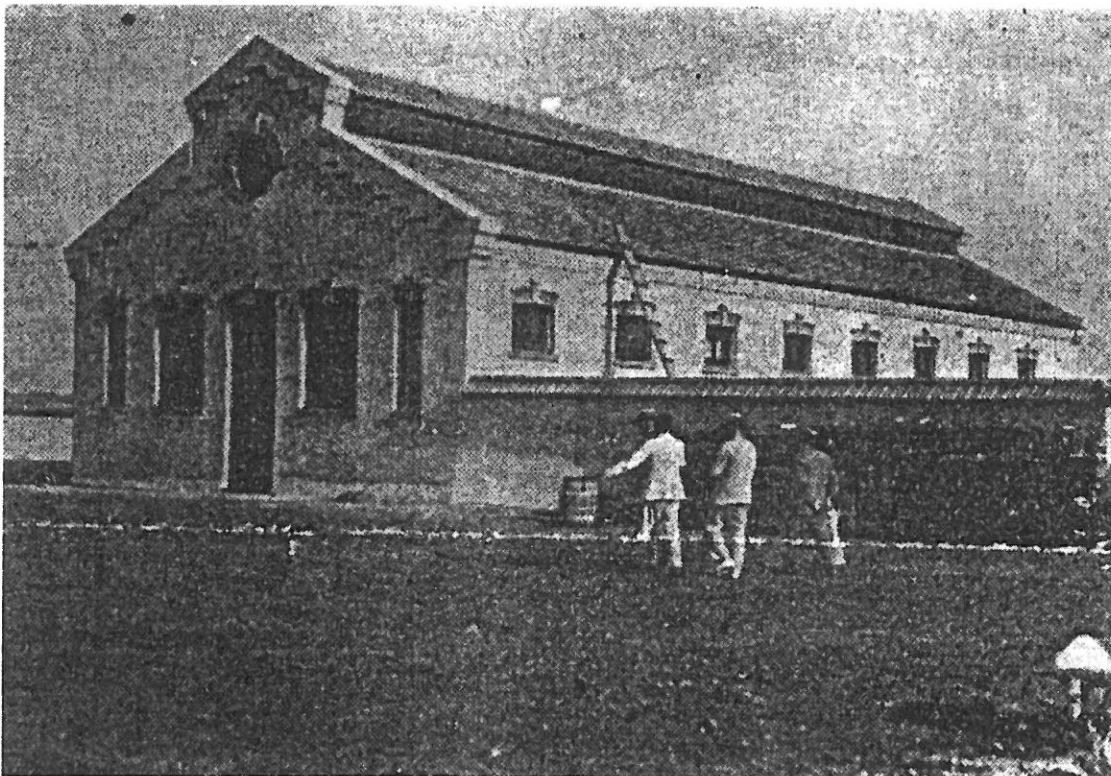
7.- Nave de establos del nuevo Matadero diseñado por el Arquitecto Fernando Guerrero Strachan en 1924-1937, en las proximidades de la barriada de Carranque.
