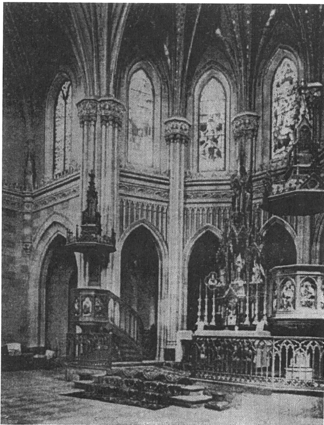
2.- Perspectiva de la Capilla Mayor de la Iglesia antes de 1931. Observéense el tabernáculo, púlpitos y vidrieras originales desaparecidos en el incendio
