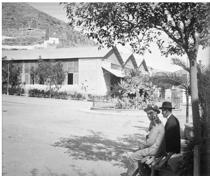
9. Francisco Roglá López, Mercado Municipal de Cullera , 1925, vista del pabellón de la sección tercera, desde el eje transversal, Biblioteca Valenciana Nicolau Primitiu. Fons Roglá
