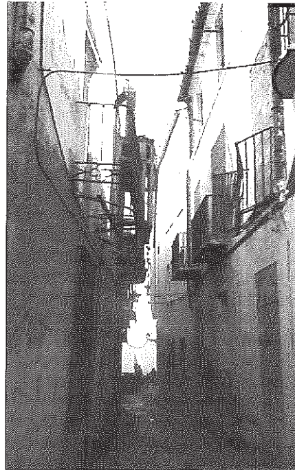
6. Calle Tomás de Cózar. Perspectiva del grave deterioro que sufren los inmuebles. Foto de la autora. 2002
