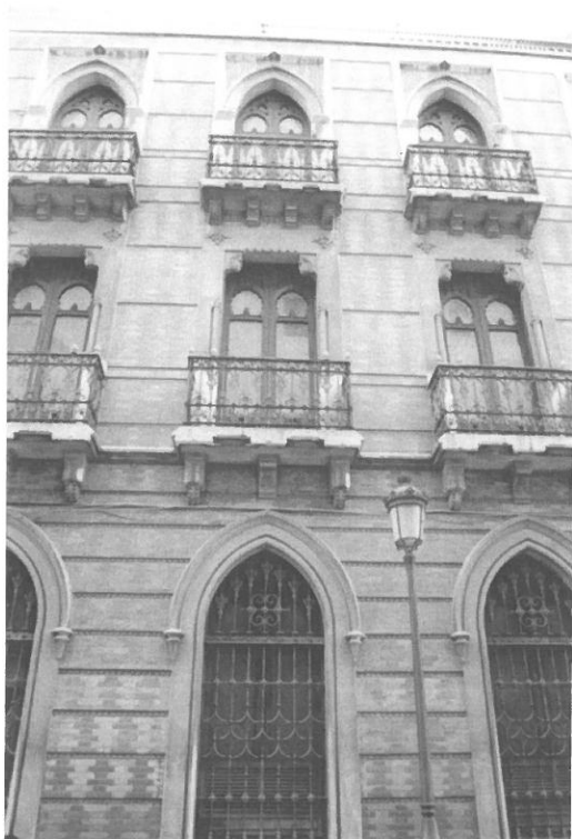
12. Detalle de la fachada del Hospital de Santo Tomás
