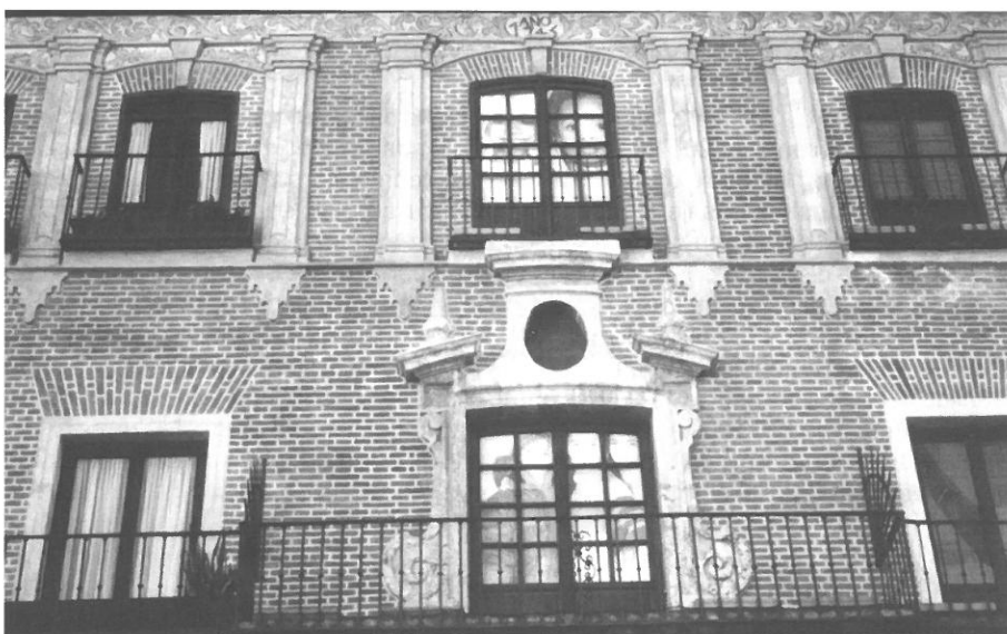
4. Detalle de la fachada principal del Pasaje de Chinitas (antiguo convento de Agustinas)
