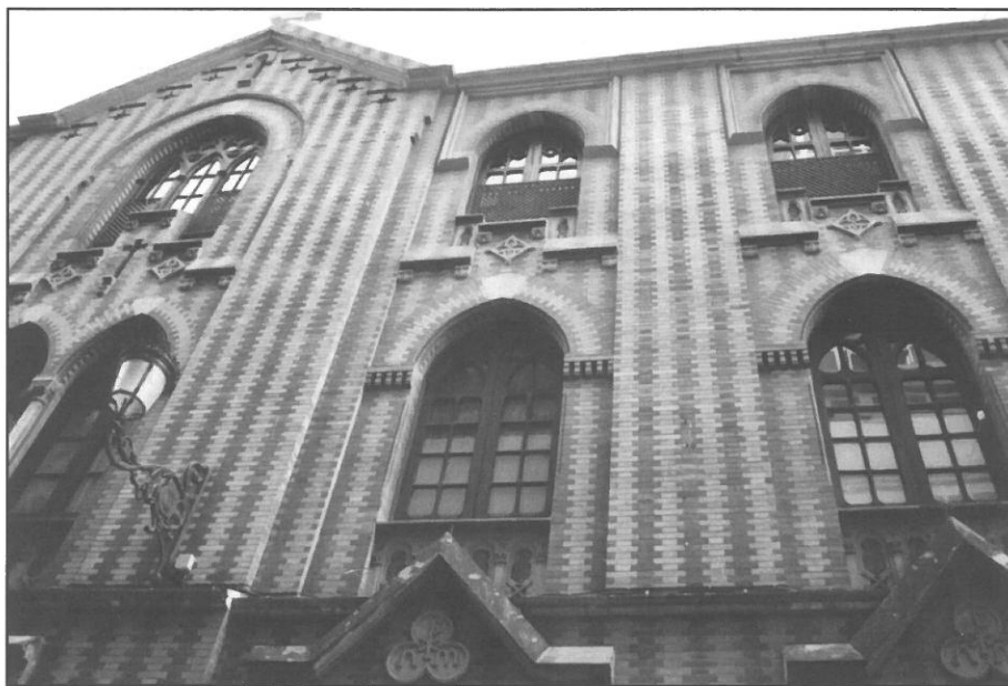
11. Detalle de la fachada del Colegio de las Esclavas
