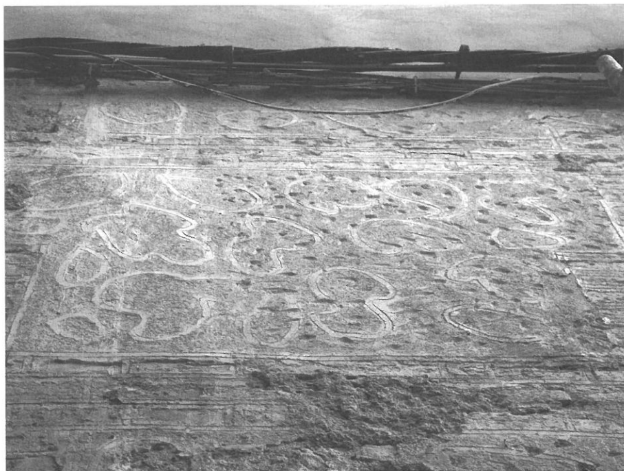
5. Resto de pinturas en una casa de Molinillo del Aceite
