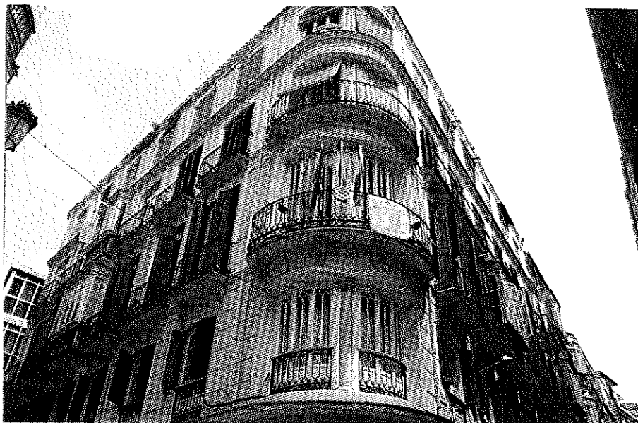
12. Edificio de calle Don Luis de Velázquez 1, esquina con Santa Lucía
