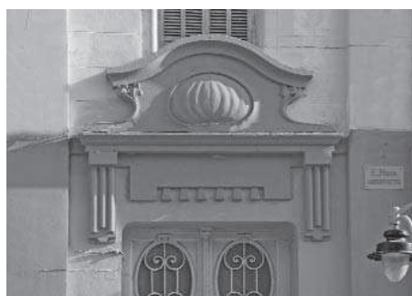
11. Vista frontal exterior del Cine Nacional, 2007. 12. Detalle ornamental de la fachada principal, 2007.
