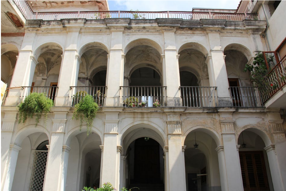
7. Episcopio di Sarno, palazzo Milone, veduta della scala aperta dal cortile (fotografie dell'autrice)
