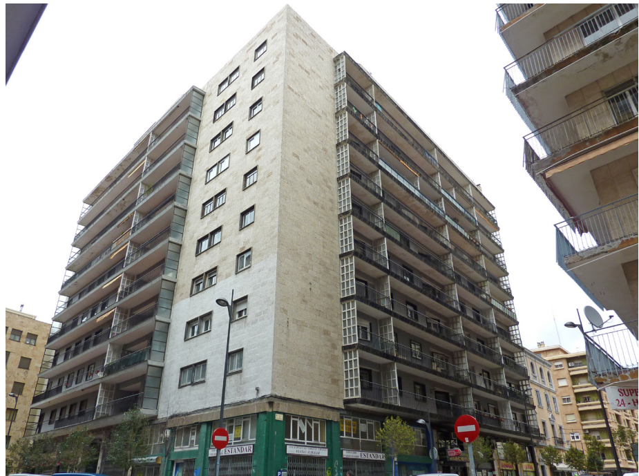
8. Fernando Población del Castillo, Edificio de Vicente Sánchez Pablos , 1958, Calles Sánchez Llevot, García de Quiñones y Rodríguez Fabrés
