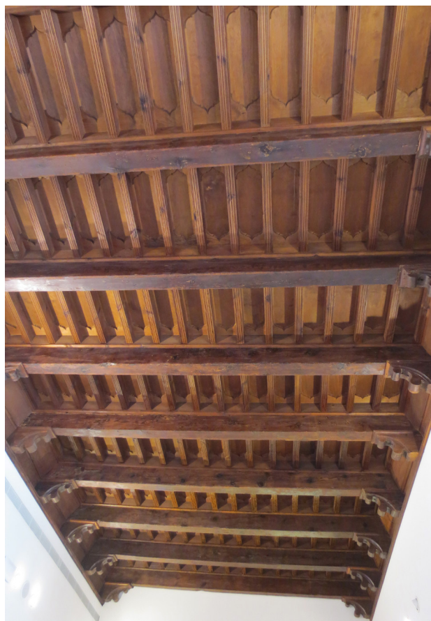
6. Palacio Villalón. Málaga
