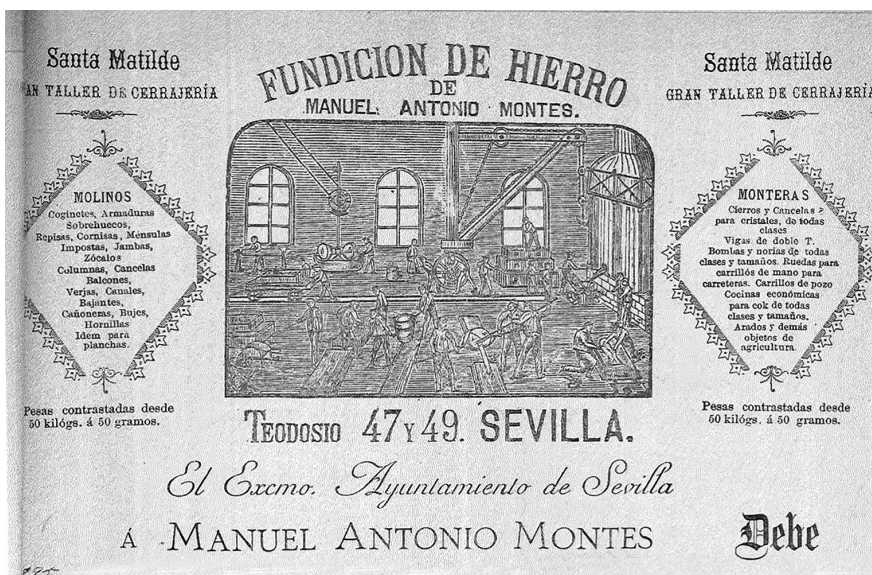
8. Detalle de la factura de la fundición de hierro Santa Matilde, de Manuel Antonio Montes dirigida al Ayuntamiento de Sevilla, 15 de agosto de 1895 (AM Sevilla, OOPP, 1894/45, s/fol.)
