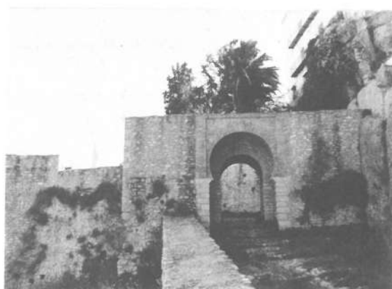
Lám. 7.— Puerta de la Cijara
