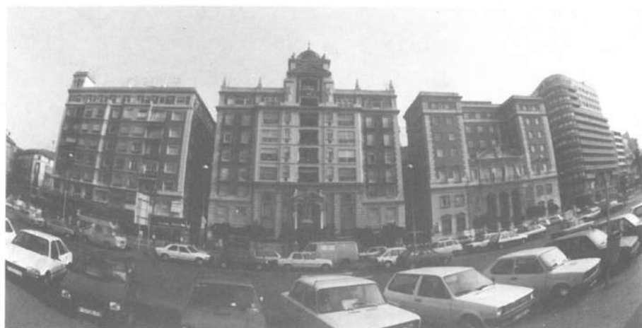
Fig. 7.- Conjunto de la Acera de la Marina.
