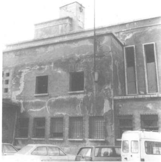
Lám. 3.- Vista de la Torre.
