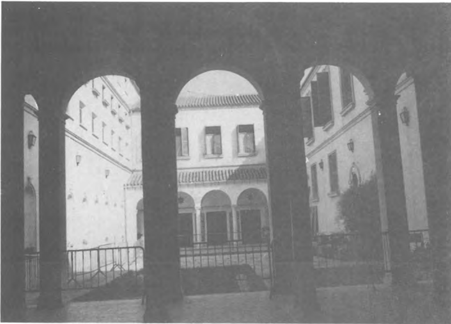
8. Patio (Estado actual).
