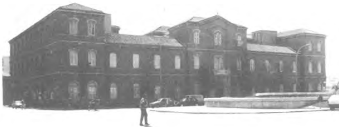
20. Asilo de San José de las Hermanitas de los Pobres.
