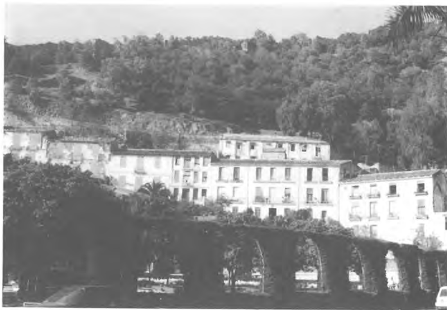
16) Estado actual de la Coracha.
