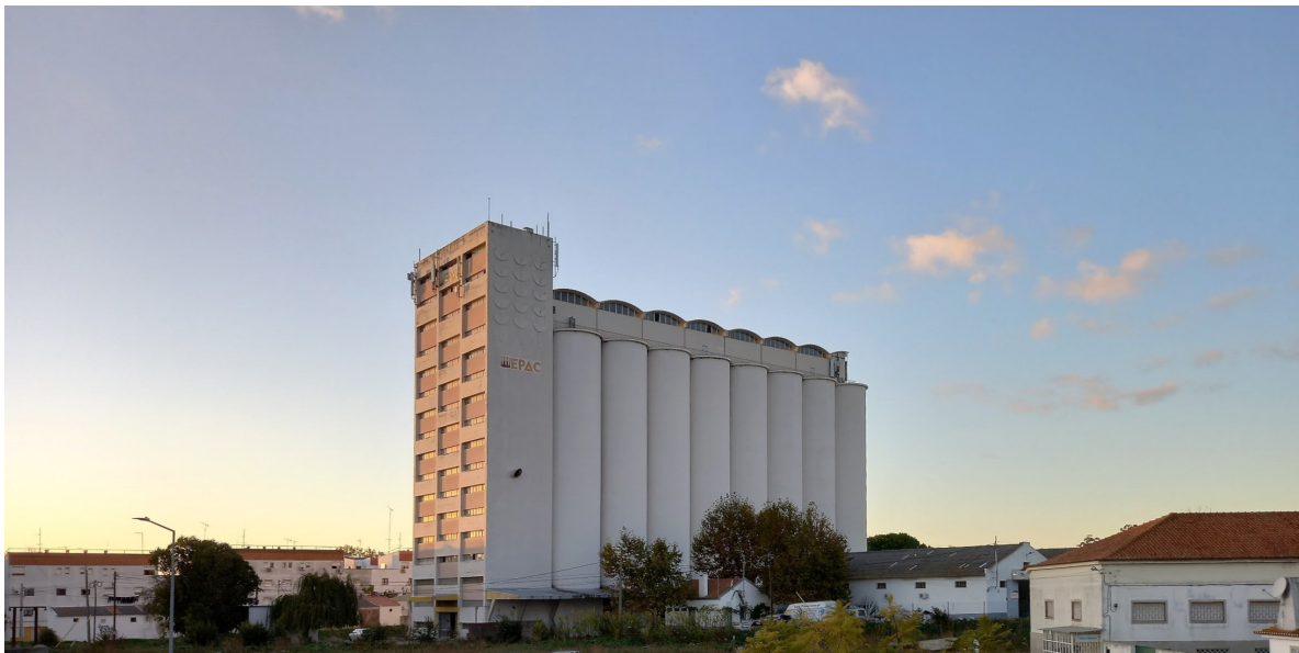
6. Silo del EPAC, Évora. Fotografía de la autora, 2021
