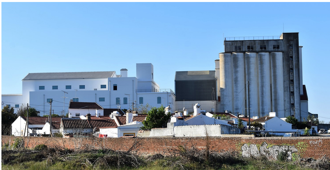
5. Exterior de la antigua Fábrica dos Leões, hoy Escuela de Arte y Arquitectura de la Universidad de Évora. Fotografía de la autora, 2021
