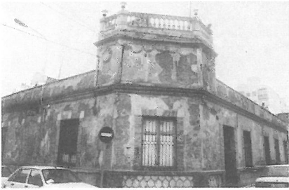
21. Casa-mata en C/ General Ibáñez esquina a C/ Fernando el Católico.
