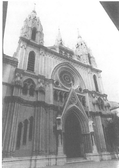
4. Fachada Principal. Iglesia del Sagrado Corazón.
