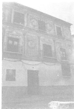
4. Granada. C/ Puente de Espinosa nº4.
