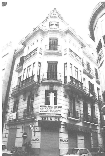
32. Edificio en c/. Echegaray esquina a Granada.
