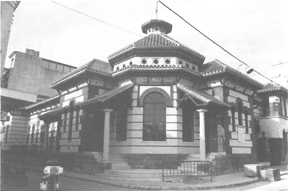
15. Casa de Socorro, estado actual.
