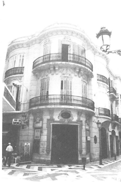
25. Edificio de viviendas en c/. Juan Díaz en la actualidad.
