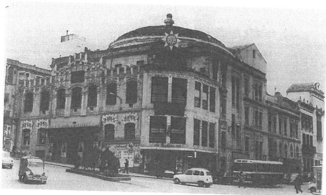
9. Vista del chaflán de visagra entre la C/ Bernabé Soriano y la Plaza del Deán Mazas tras las mutilaciones en la fachada (Ortega).
