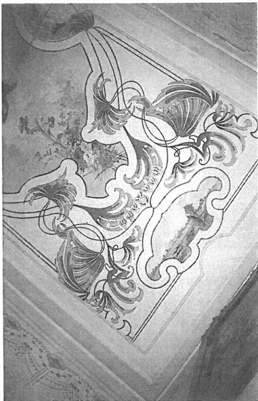
Fig. 7.— Detalle del techo de la segunda planta.
