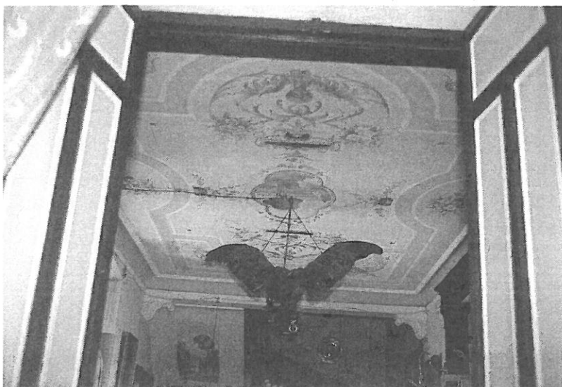
Fig. 6.— Distribuidor de la primera planta.
