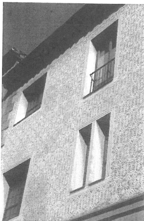
Fig.8.- Esgrafiado madrileño. Fachada del edificio de la Seguridad Social en la C/Segovia.
