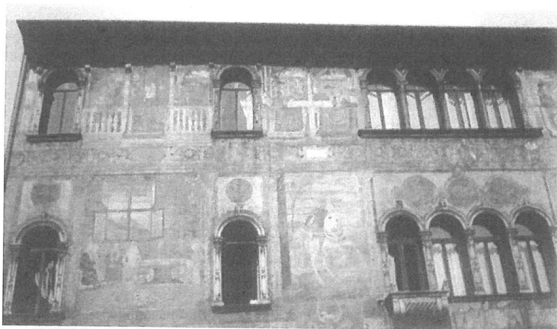
Fig.11.- Trampantojo en fachada del Palacio Jeremías. Trento (s.XVI).
