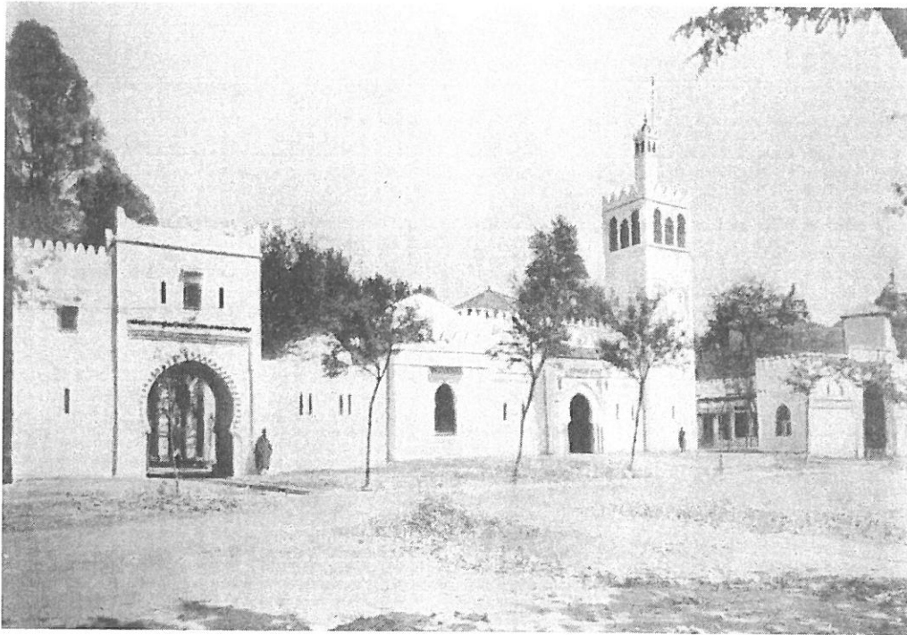
Fig. 5.— Pabellón oficial ya construido. Fachada principal.
