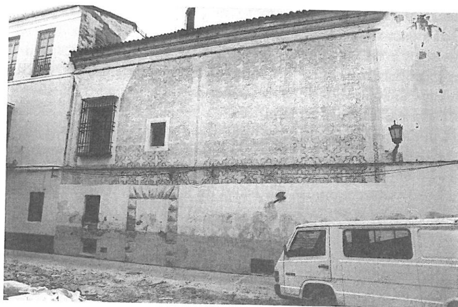
Fig. 2.— Decoración esgrafiada del muro exterior de la capilla del conjunto palaciego de los Condes de Buenavista en calle Gaona (Iglesia de San Felipe).
