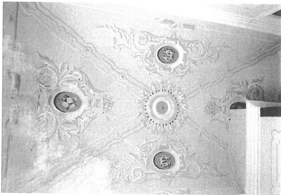
16.- Granada, 33. Pinturas bóveda escalera.
