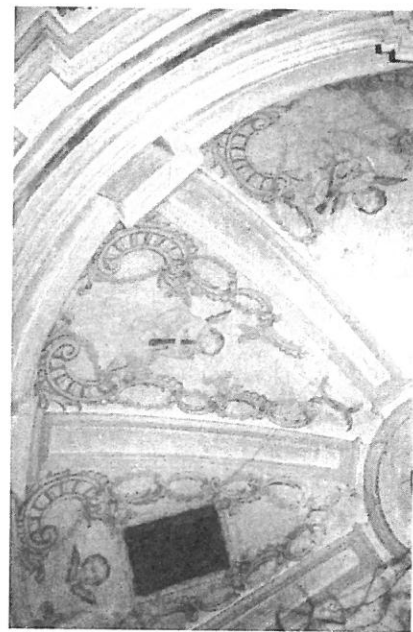
7.- Oratorio de la c/ Santa Cecilia. Detalle de la bóveda.
