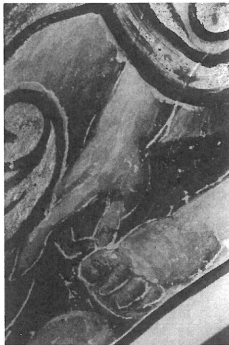
21.- Superposición de elementos de los siglos XVI y XVIII en las enjutas de los arcos, durante el proceso de restauración.
