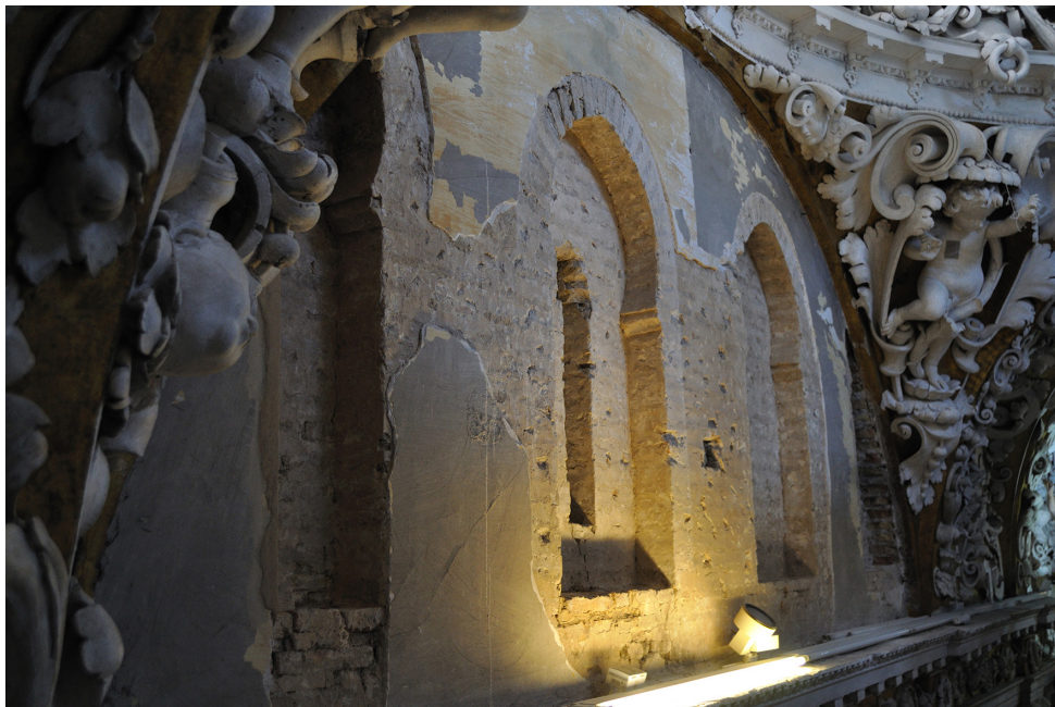
2. Arcos de herradura con saeteras de ventilación. Crucero
