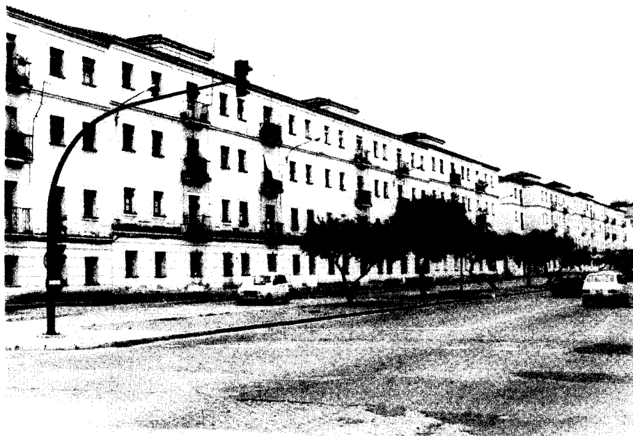
Foto n° 8. Barriada del Generalísimo Franco (Carranque). Aspecto de la fachada pantalla.
