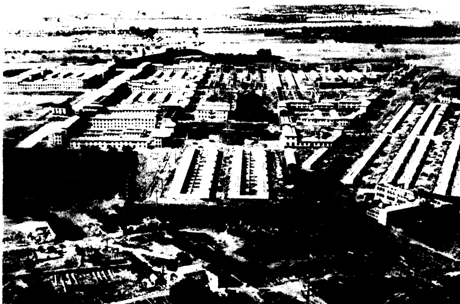
Foto nº 4. Barriada del Generalísimo Franco (Carranque). Vista de los momentos finales de su construcción.
